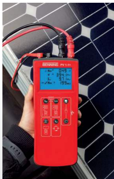
Automessung am PV-Strang ( U_{oc} , I_{sc} , R_{iso} )
